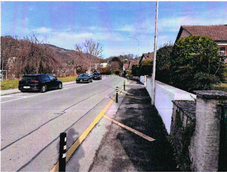
Figure 4 - Exemple d'aménagement : bande piétonne et potelets
