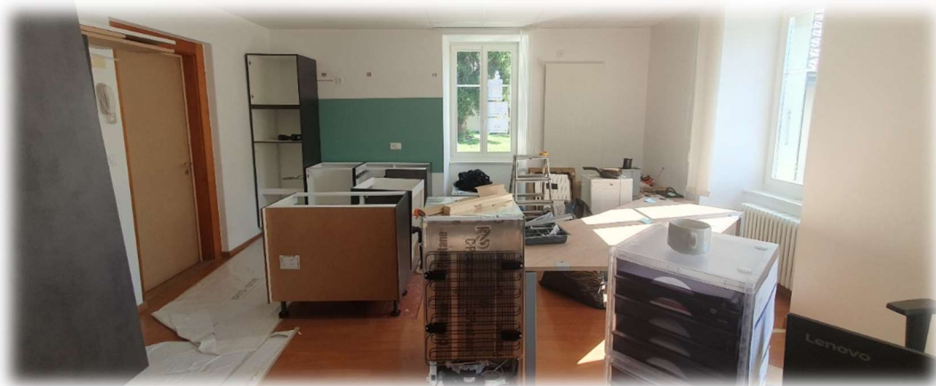
Photo : pendant les travaux
